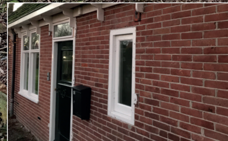
Restauratie gevels en voegwerk
