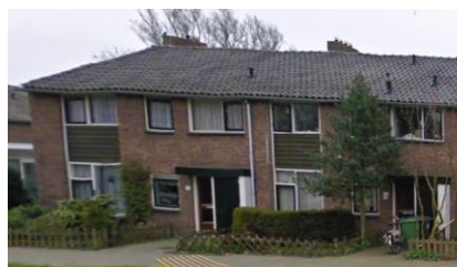
Jaap Weijandweg: Groot onderhoud van 58 beneden- en bovenwoningen. Start renovatie 2017, oplevering 2018.
