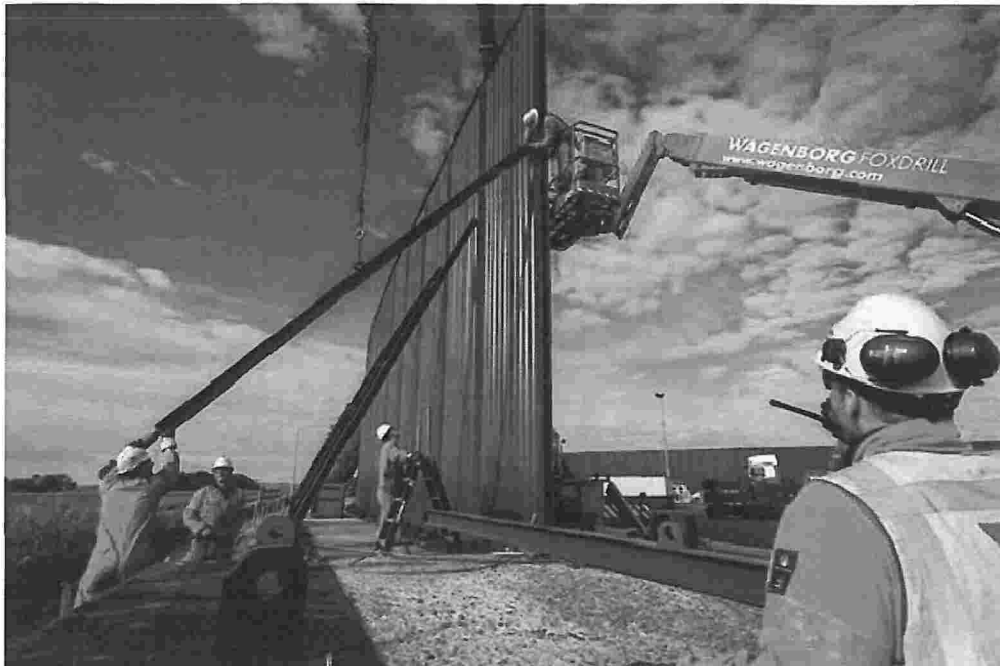
Figuur 4: Opbouwen geluidscherm op westelijk deel van de Bergermeerlocatie
